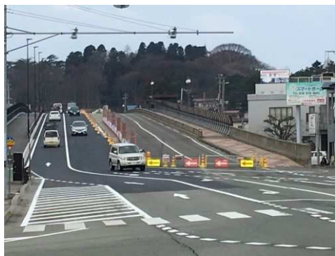
【橋梁の拡幅・耐震補強等による防災性能の向上】 3・4・27千秋広面線 秋田市手形陸橋
